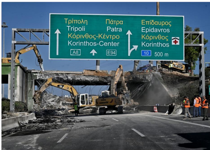
Kuva 25 Seuraavana aamuna siltaa jo purettiin.
