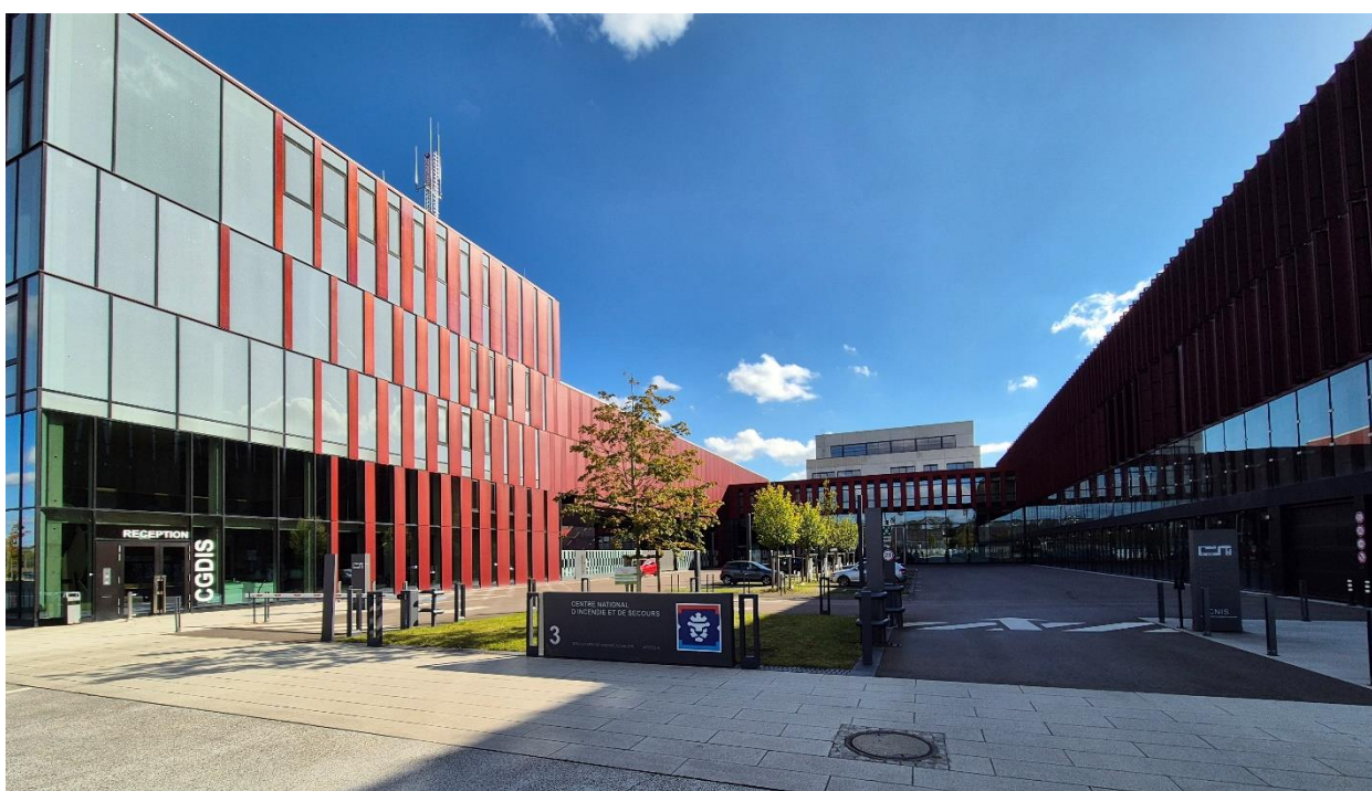
Kuva 26 Luxemburgin paloasema rakennuksen ulkopuolelta.
